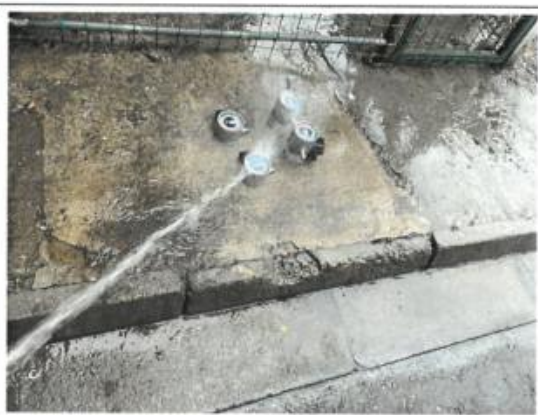
图 17.2024-0102-2# 防水试验中照片
