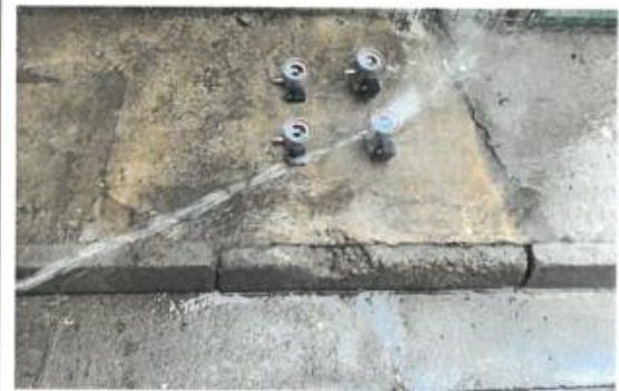
图 18.2024-0102-3# 防水试验中照片
