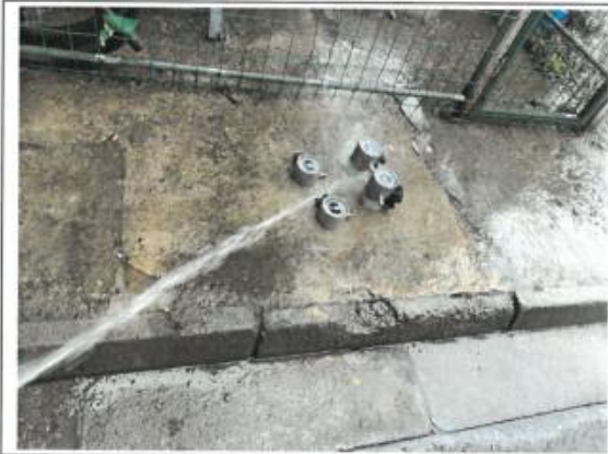
图 16.2024-0102-1# 防水试验中照片
