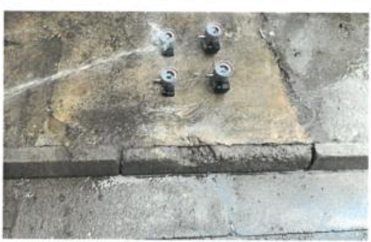
图 19.2024-0102-4# 防水试验中照片
